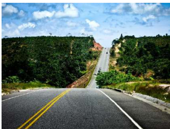
Trecho rodoviário da Linha Verde
